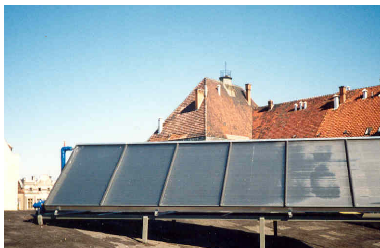
Rys. 10. Kolektor słoneczny firmy Wagner z absorberem płaskim z warstwą TiNOx
