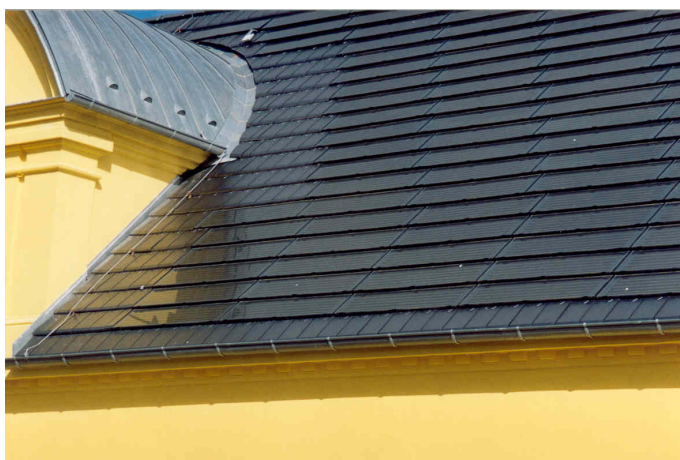
Rys. 7. Dach budynku z paneli fotowoltaicznych
