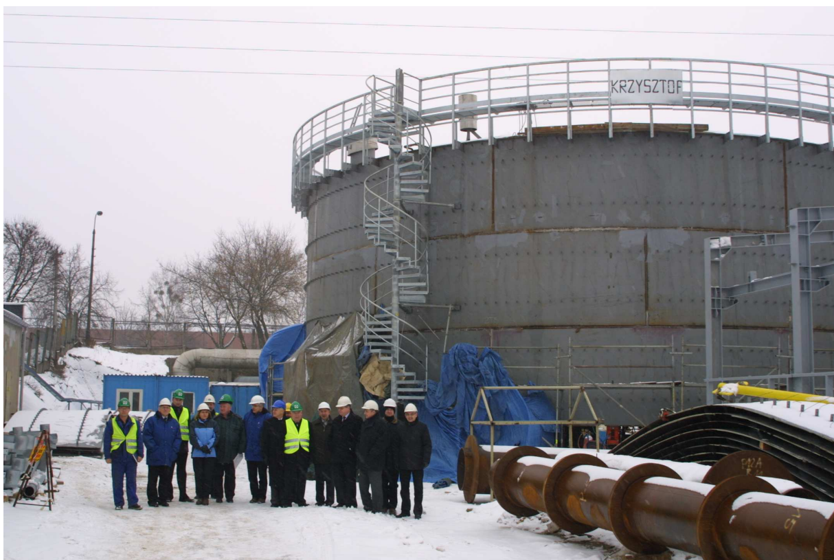
2_ Akumulator bezciśnieniowy stanął na terenie zdemontowanej, wyeksploatowanej suchej chłodni wody sieciowej
