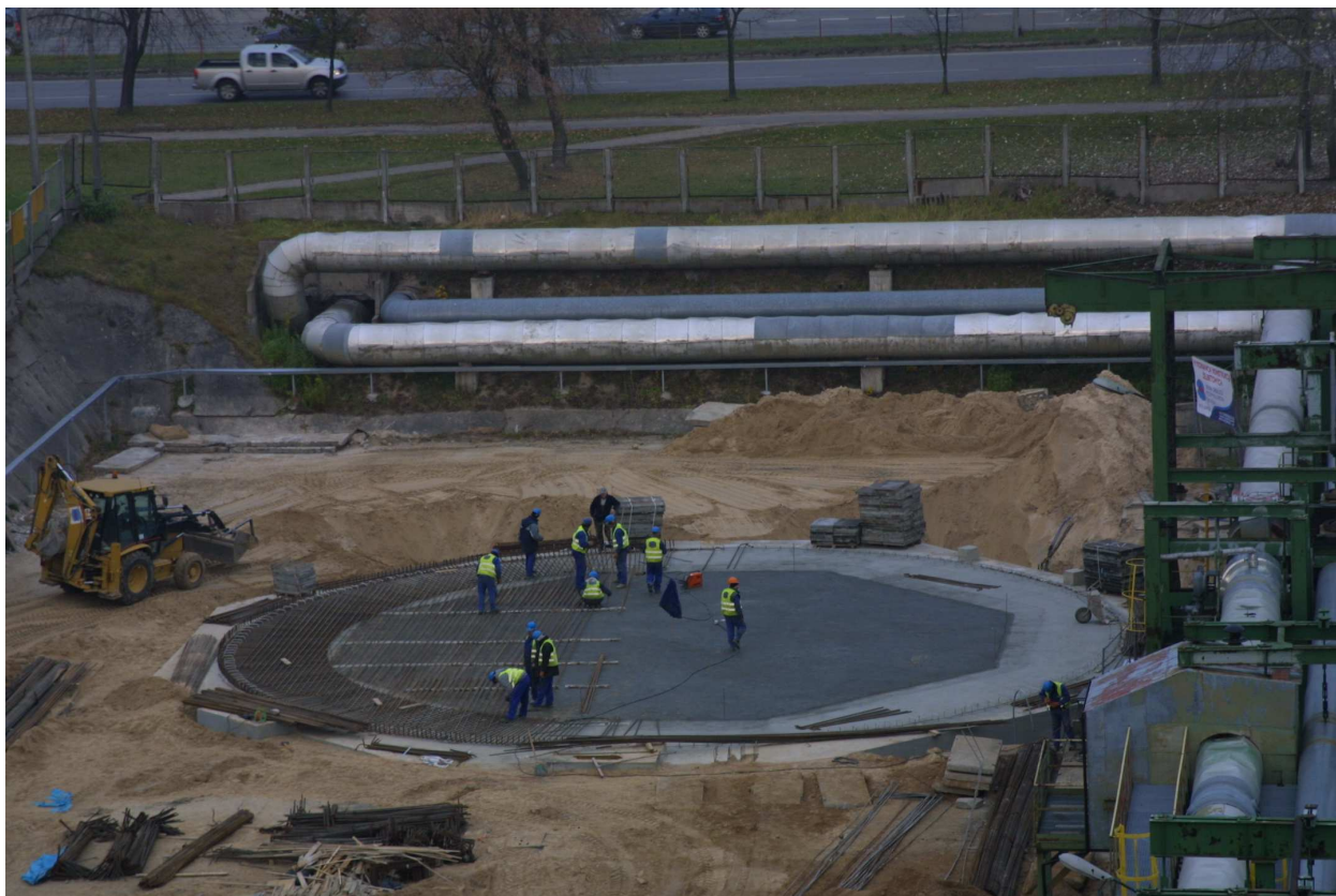
1_ Budowa akumulatora ciepła w Elektrociepłowni Białystok ruszyła 8 lipca 2010 roku
