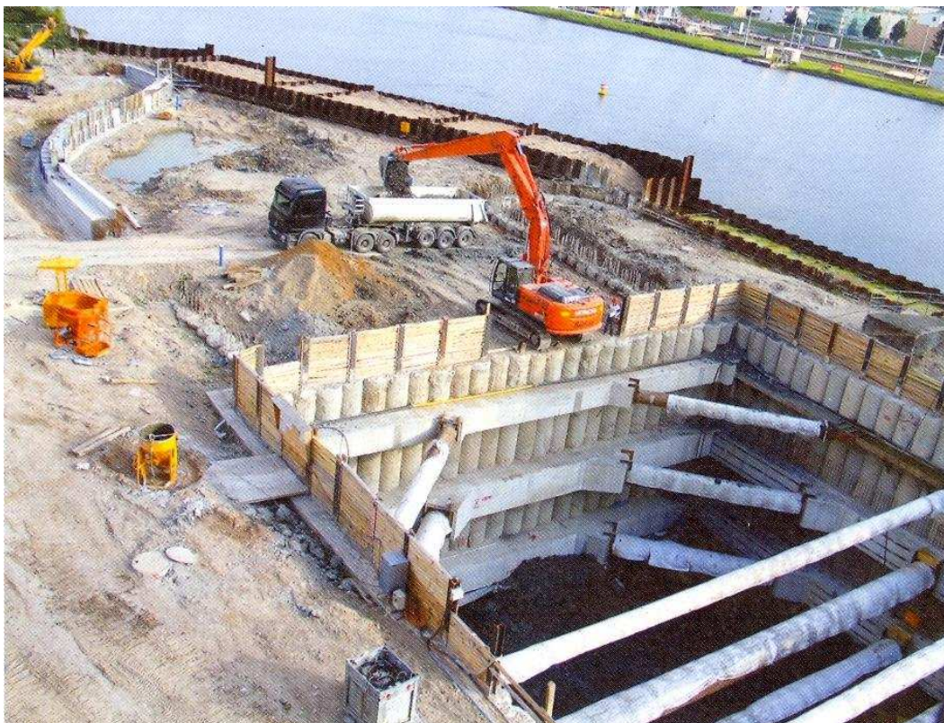
Rys. 1. Kanał dopływu wody do betonowej komory dwóch turbin sprzężonych z elektrogeneratorami o mocy 4,0 MW.
