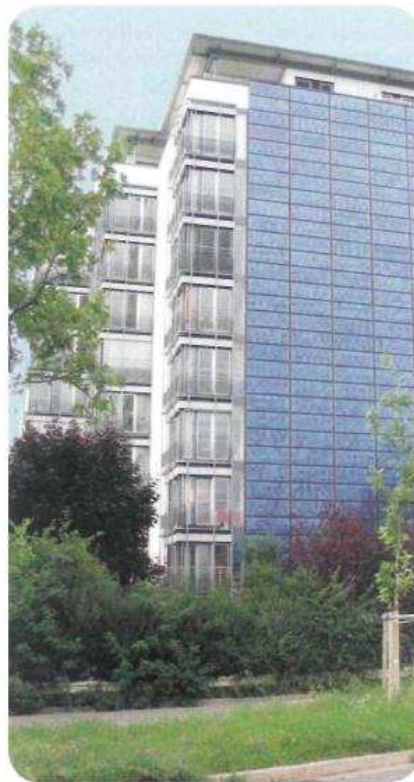
Rys. 3. Na południowej fasadzie starego budynku zainstalowano baterie fotowoltaiczne, zasilające mieszkańców w energię elektryczną
