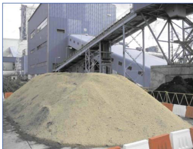
Rys. 5. Operacyjne składowisko biomasy z ciągiem nawęglania
