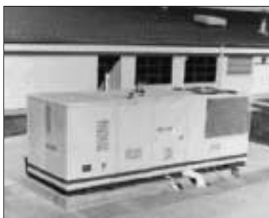
Generator firmy Balard Power System o mocy 250 kW (instalacja użytkowa w Cinergy USA)
