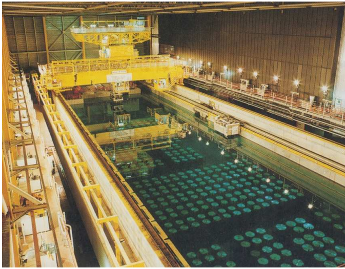
Rys. 4. Basen magazynowy w THORP ( T hermal O xide R eprocessing P lant) w Sellafield (Wielka Brytania)
