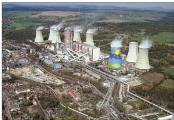
Widok Elektrowni Turów pod koniec modernizacji bloku 6.
