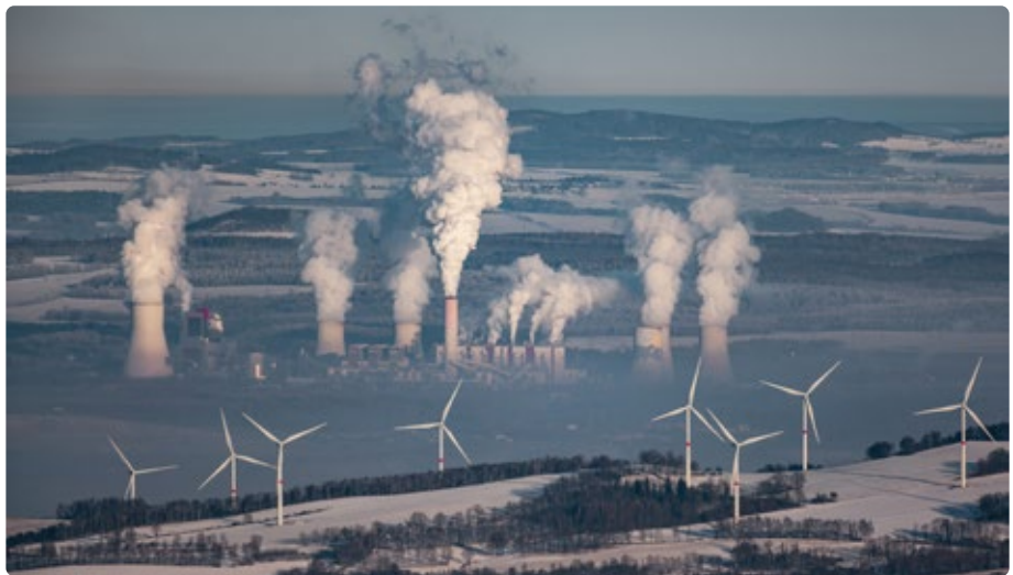
Fot. 1. Elektrownia Turów
