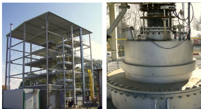
Rys. 3. Widok demonstracyjnej instalacji zgazowania o mocy 1,5 \text{ MW}_t oraz generatora gazu
