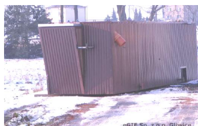
Rys. 2. Komercyjna mikrobiogazownia KMR 7 [2]
