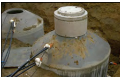
Rys. 6. Widok zbiorników w trakcie montażu [5]
