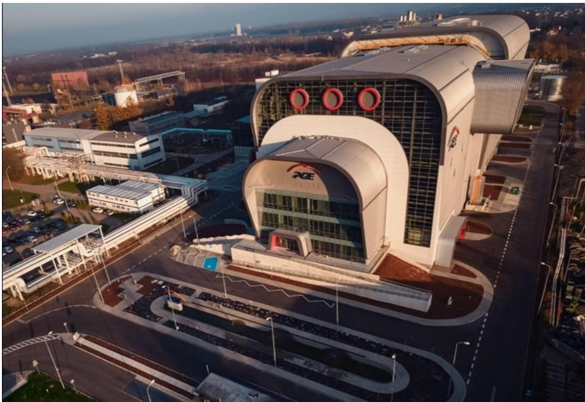
Rys. 11. Spalarnia odpadów komunalnych w Rzeszowie
