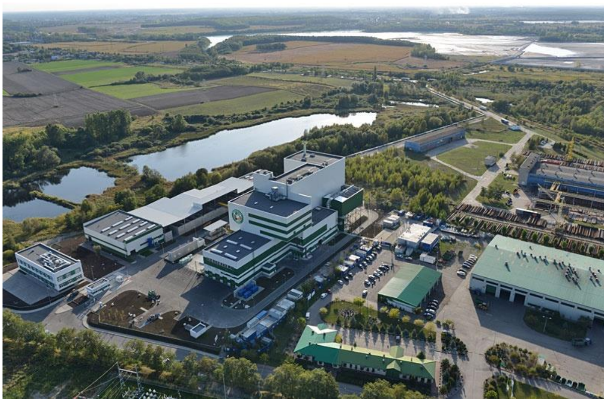
Rys. 3. Spalarnia odpadów komunalnych w Koninie
