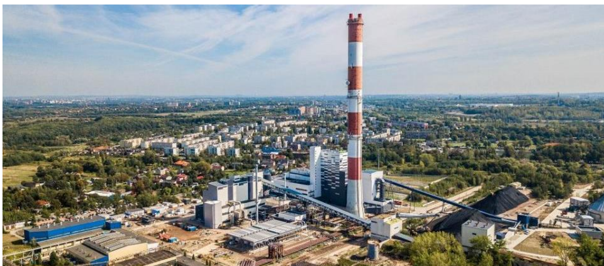
Rys. 13. Elektrociepłownia FORTUM w Zabrzu z kotłem wielopaliwowym
