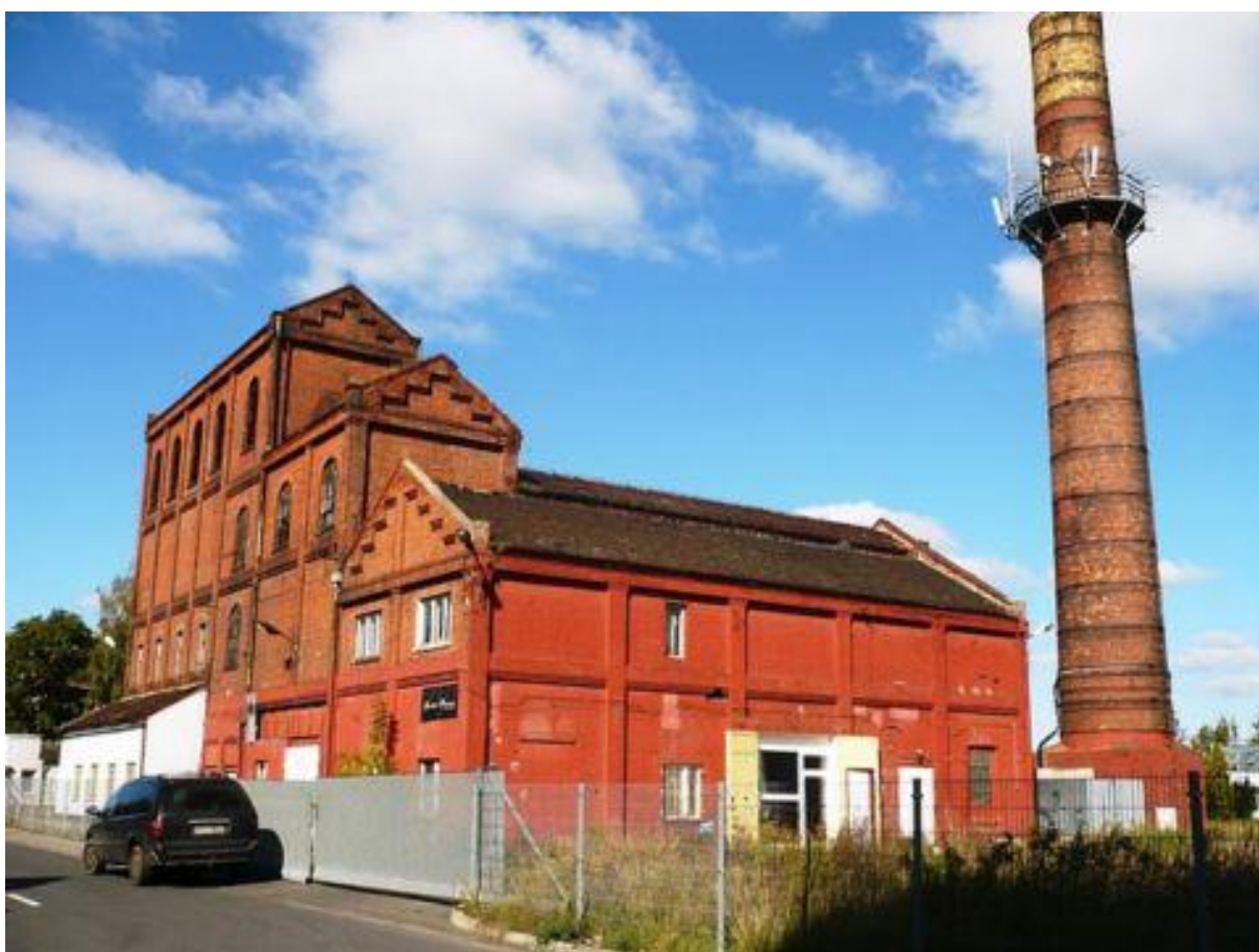
Rys. 1. Pierwsza poznańska spalarnia odpadów komunalnych „na Wilczaku”
