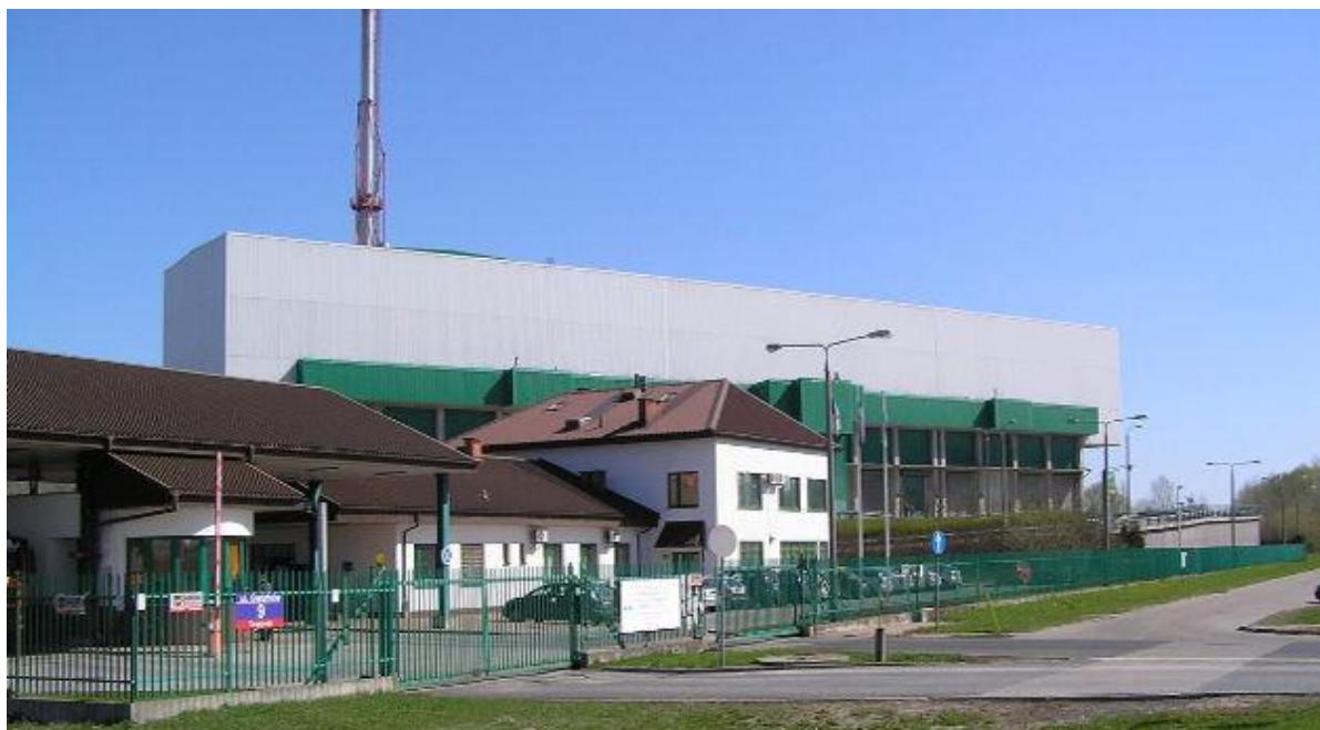
Rys. 2. Spalarnia odpadów komunalnych w Warszawie
