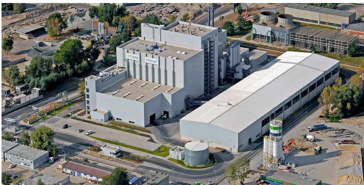
Rys. 8. Spalarnia odpadów komunalnych w Poznaniu
