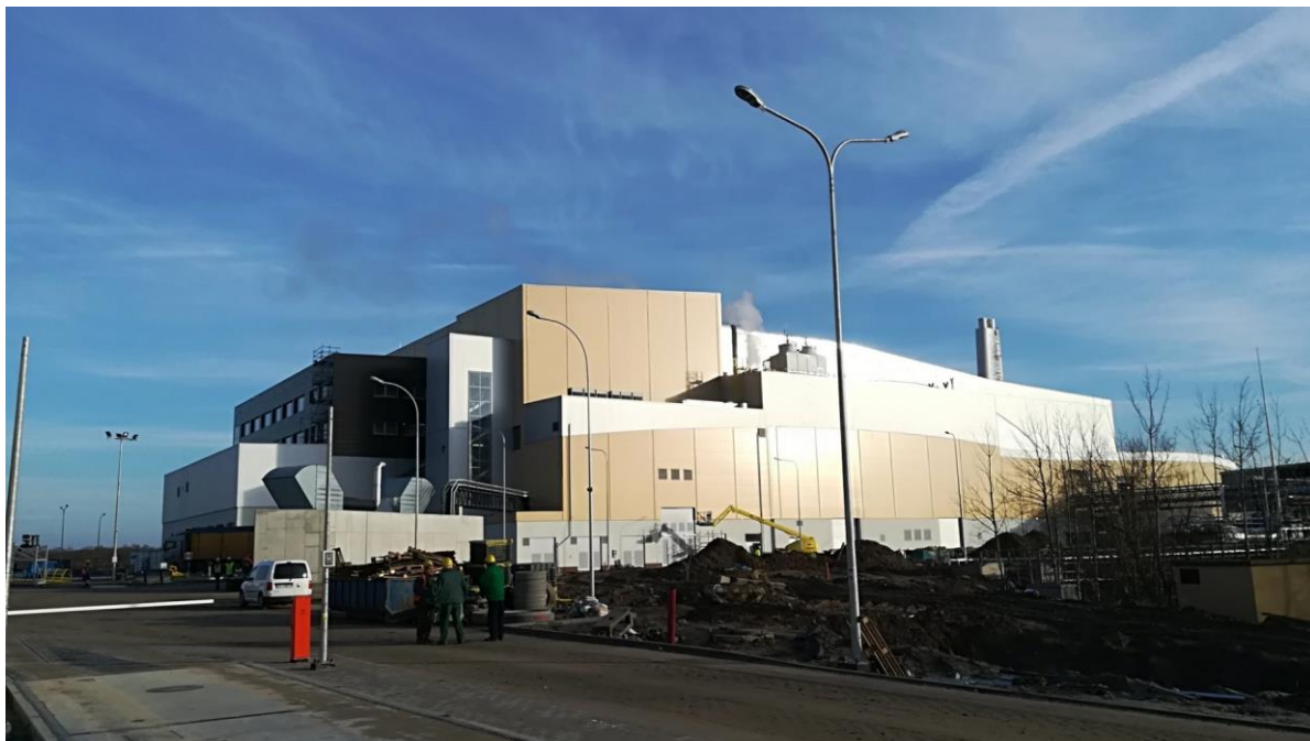
Rys. 10. Spalarnia odpadów komunalnych w Szczecinie
