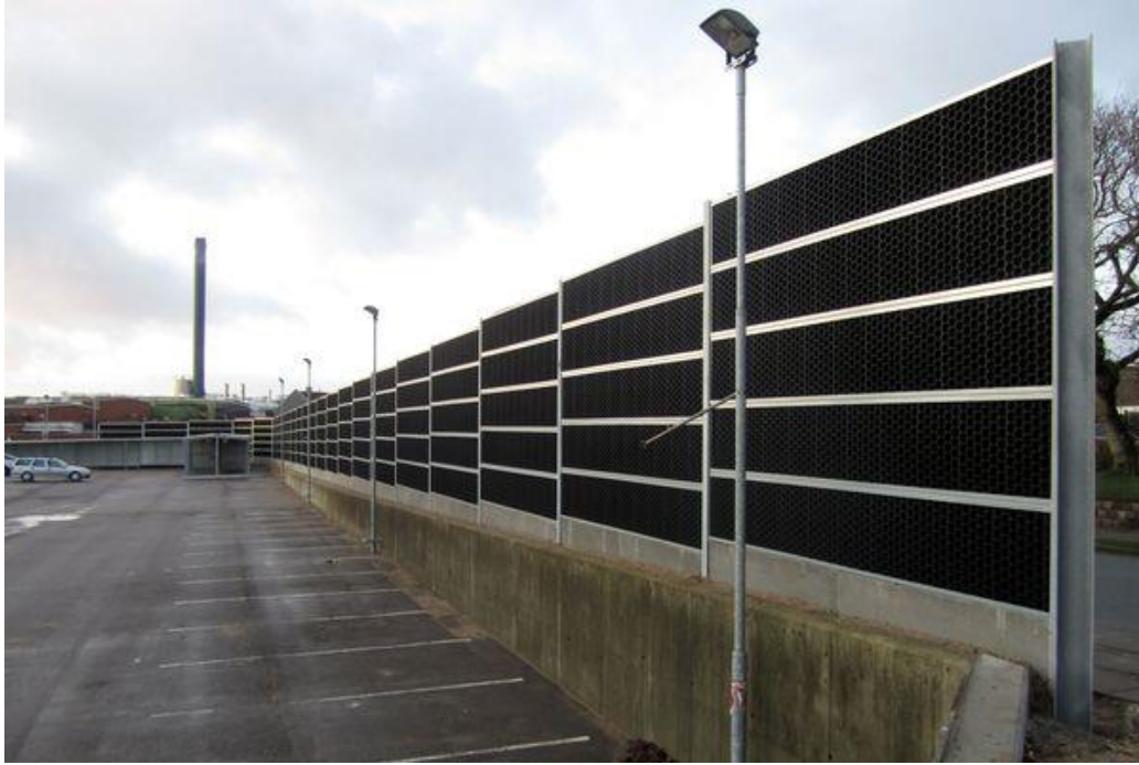
Bariery dźwiękochłonne z kasetami zawierającymi absorbent akustyczny z włókna szklanego turbin wiatrowych
