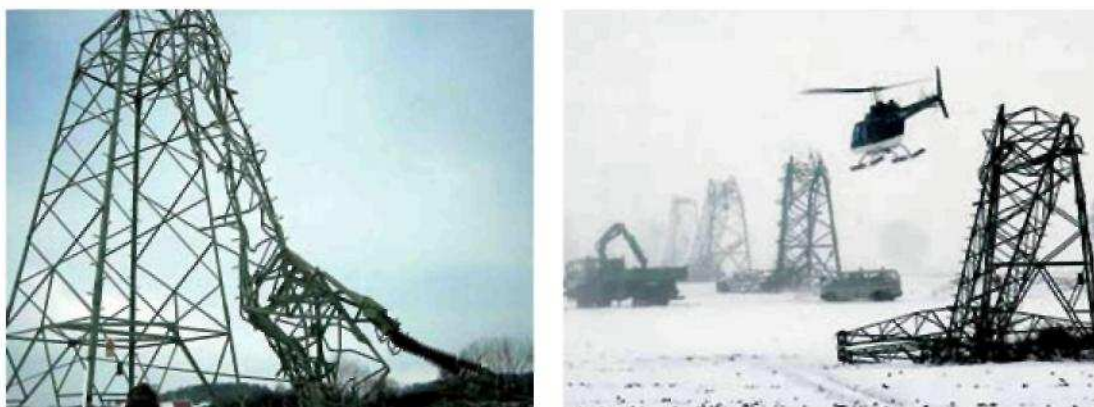
Rys. 9. Skutki burzy śnieżnej w Niemczech, 24-25 listopada 2005 – linie E.ON-u [5, 21]
