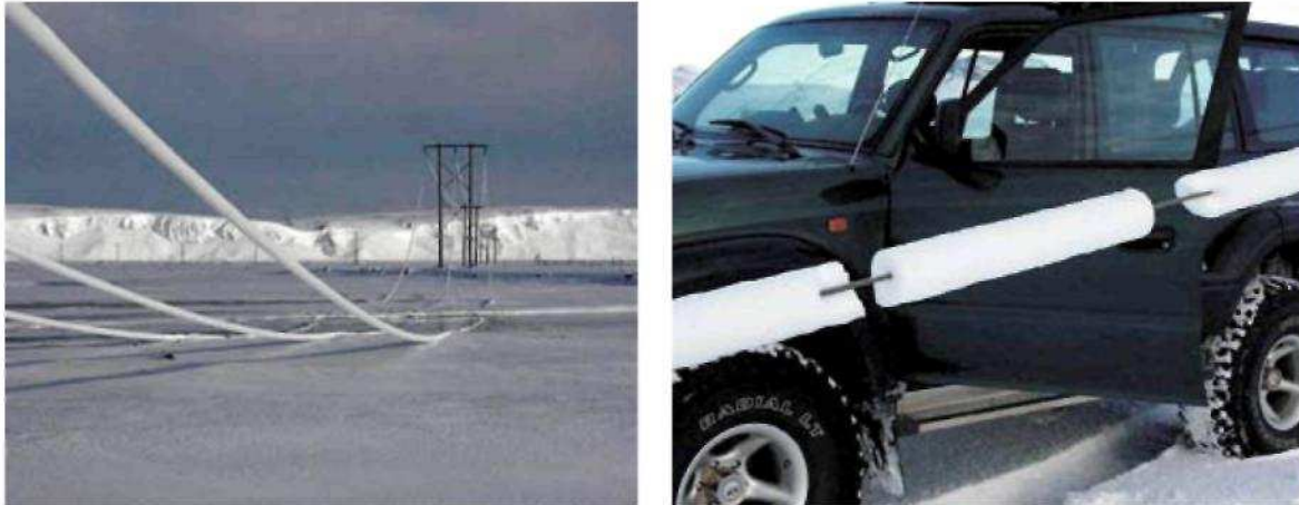
Rys. 10. Przęśło o rozpiętości 268 m i osad lodowy na przewodzie [22]
