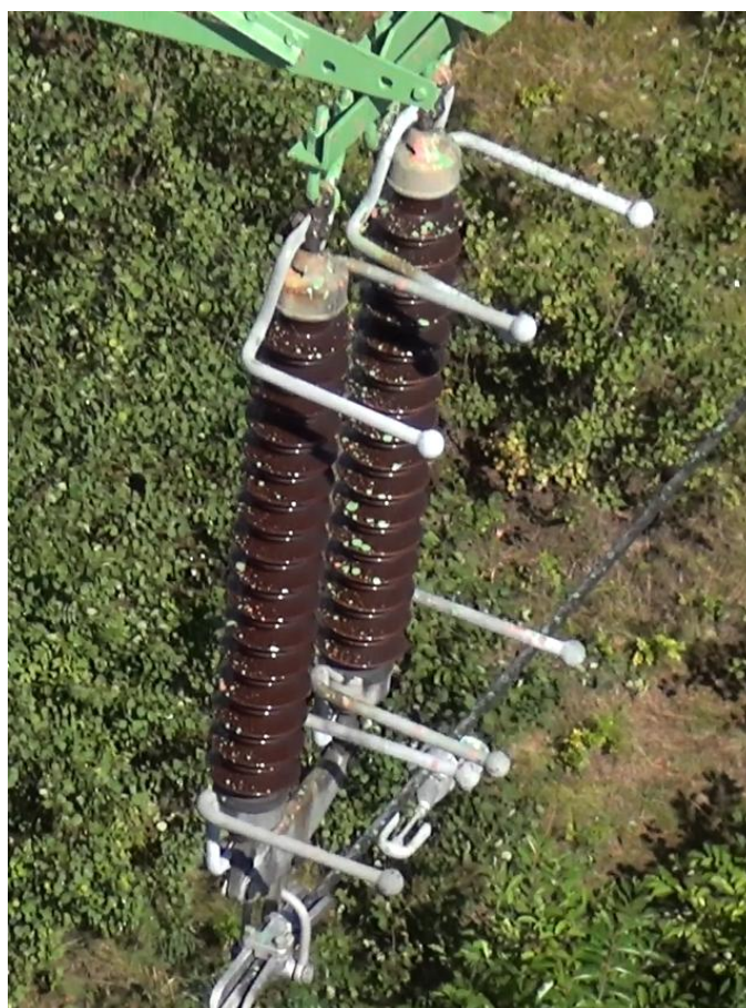
Film nakręcony przez drona pozwala z bliska zweryfikować stan osprzętu linii WN po wykonaniu malowania
